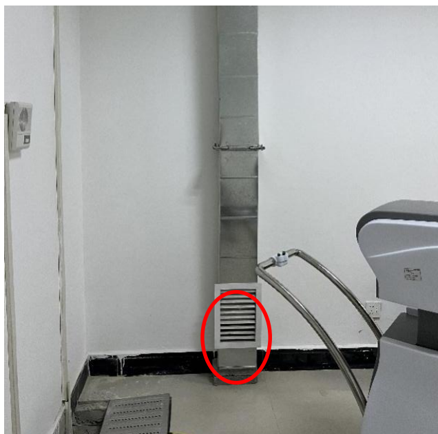
图 3-3 后装机房间内排风口
