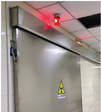
工作状态指示灯、电离辐射警告标志
