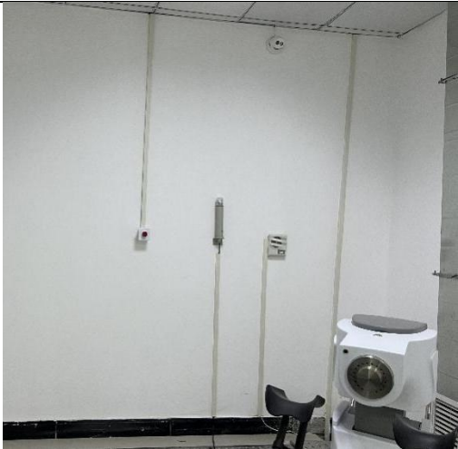
固定式剂量报警仪、视频监控、对讲系统
