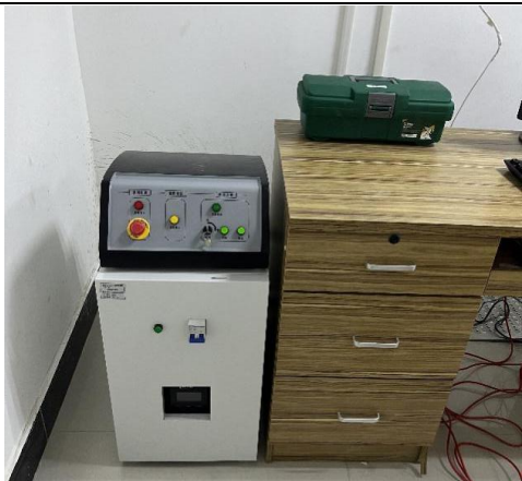
钥匙开关、控制台急停、UPS 电源
